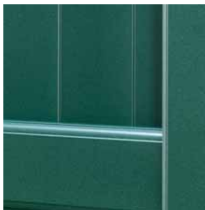
Particolare nodo di giunzione traverso centrale/montante.
